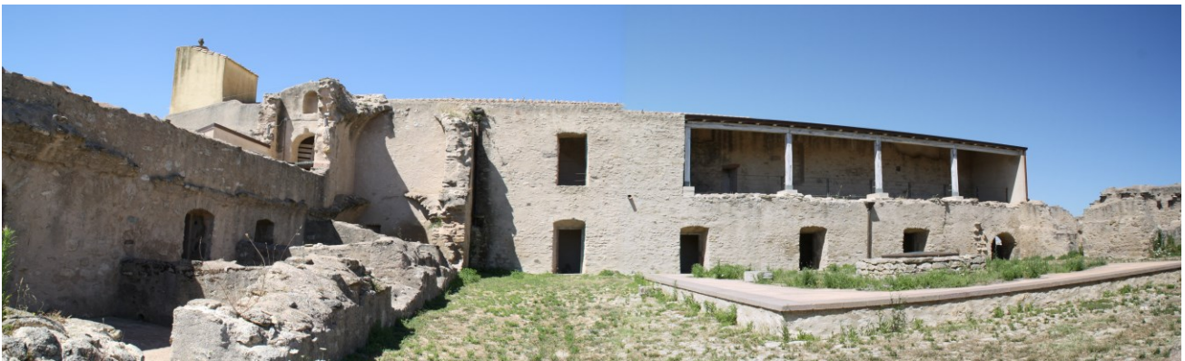
Foto panoramica prospetto lato Convento
