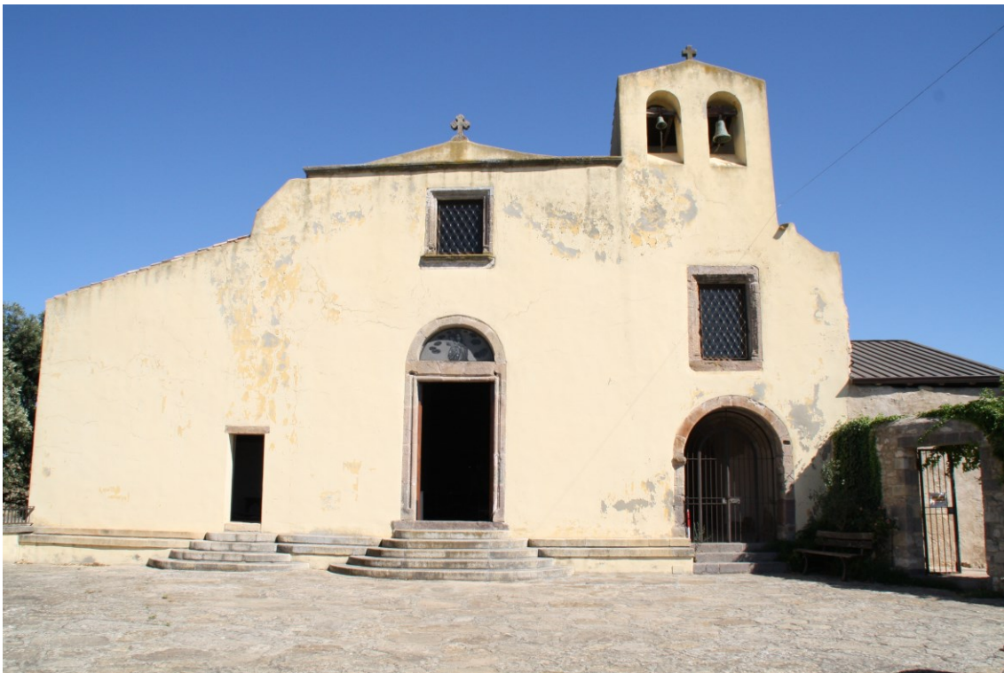
Foto facciata principale
